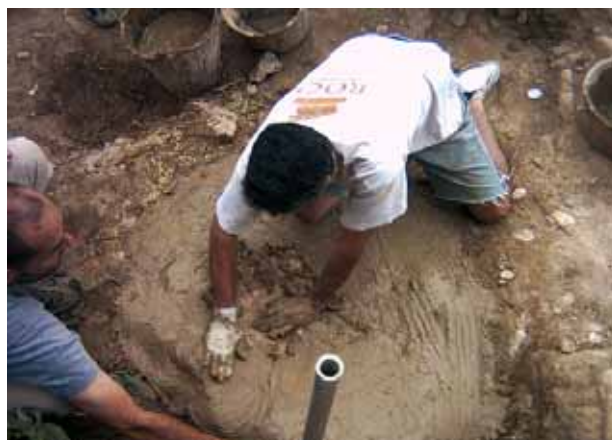
Figura 5. Sellado del silo.
