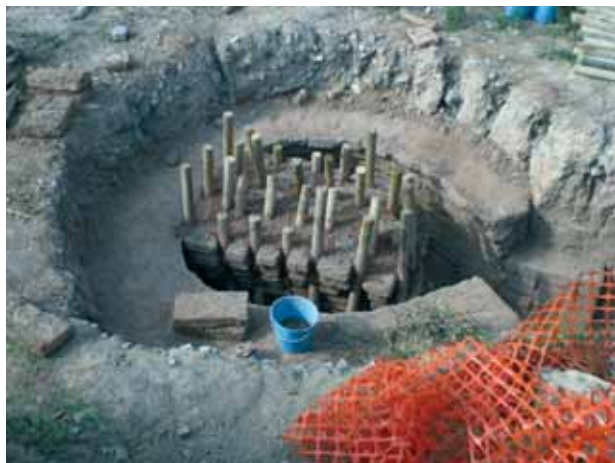
Figura 9. Detalles de la cámara de combustión a medida que ésta se va cerrando
