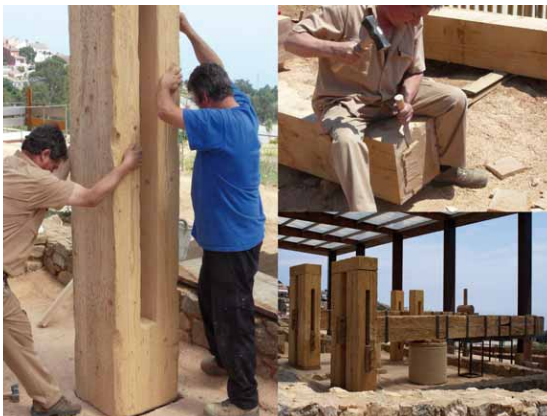
Figura 2. Proceso de reconstrucción in situ de las dos prensas romanas de biga
