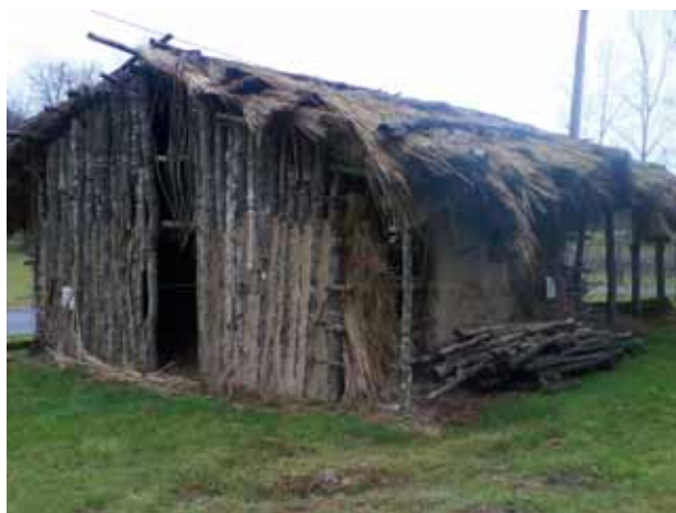
Figure 11. La nouvelle maison en cours vue arrière
