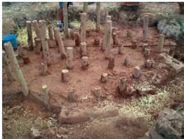
Figura 11. Parrilla a punto de terminar su regularización
