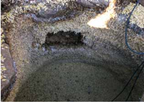
Figura 7. Vaciado del silo y cata de la pared
