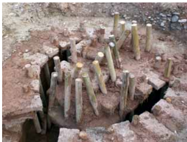
Figura 10. Cerramiento de la cámara de combustión. La parrilla se va configurando
