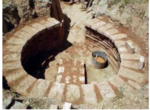
Figura 7. Pared perimetral de la cámara de combustión y arranque del pilar central
