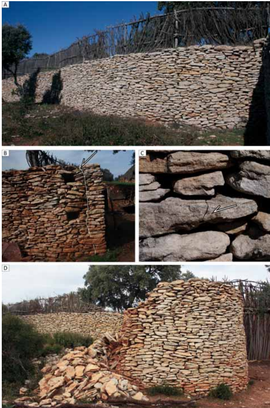
Figura 6. A. Vista del alzado de la muralla donde se observa el estado de conservación de esta. B. Detalle de la aparición de grietas que recorren el alzado en sentido longitudinal y provocan la desestabilización de la estructura. C. Detalle de grietas en la mampostería debido a los procesos relacionados con la carga. D. Vista del derrumbe de un tramo de la muralla tras las intensas lluvias acaecidas a finales del 2009 y comienzos del 2010
