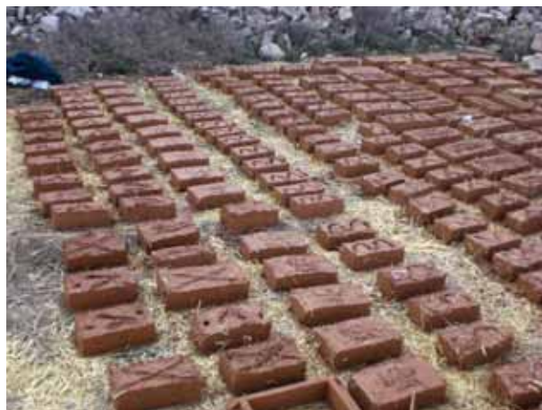
Figura 5. Extensión de adobes para la construcción de la cámara de combustión
